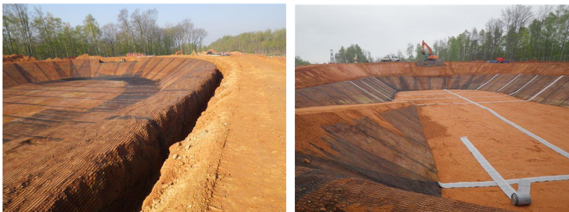
Figure 10 : Pose de la géogrille avec ancrage, mise en place des 0.20 m de sable et des bandes de dégazage
